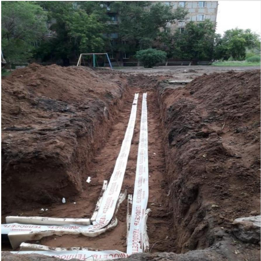
Реконструкция проводится путем замены изношенных участков трубопровода посредством применения предизолированной трубы в бесканальной прокладке
